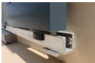
Cornière aluminium filant + olive réglable
