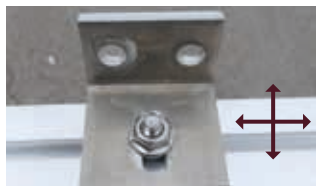
Équerre réglable dans les deux sens
