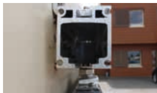
Rail simple pose en applique sur façade
