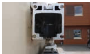
Rail simple pose en applique sur façade
