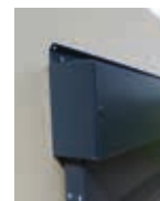
Cache-rail plié vissé sur rail et embout
