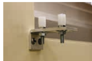
Platine olive pour volet double rail
