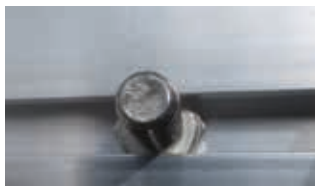
Rail aluminium avec boulon coulissant
