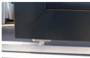
U aluminium filant fixé au sol + olive réglable
