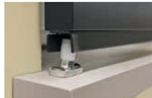
Olive réglable fixée sur appui débordant
