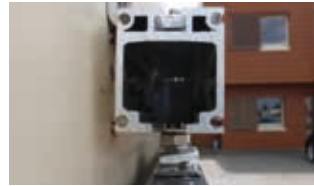
Rail simple pose en applique sur façade
