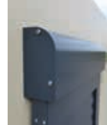
Cache-rail arrondi clipsé sur rail et embout
