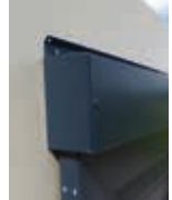
Cache-rail plié vissé sur rail et embout
